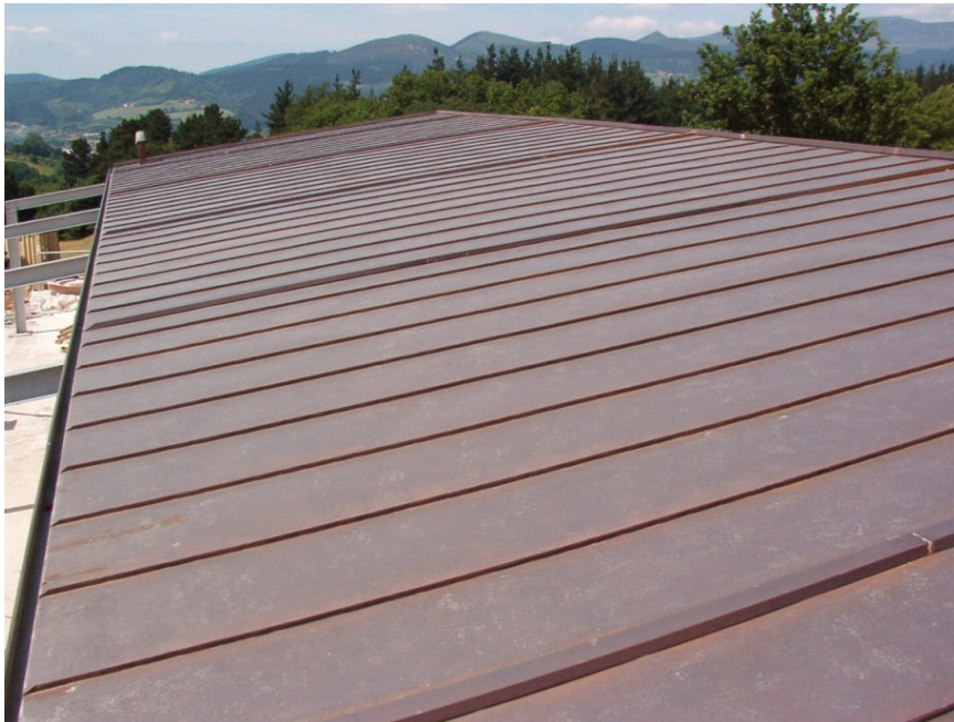
Pabellón de caza, Bitaño, Durango, Vizcaya. Cubierta de junta alzada
