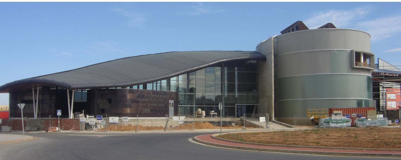
Centro Tecma, Alzira. Cubierta de junta alzada
